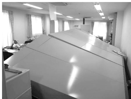
大きく前後に揺れながら最後に転倒。机や PC を押し潰した。キャビネットの天板と天井の間にはわずかだが隙間があった
